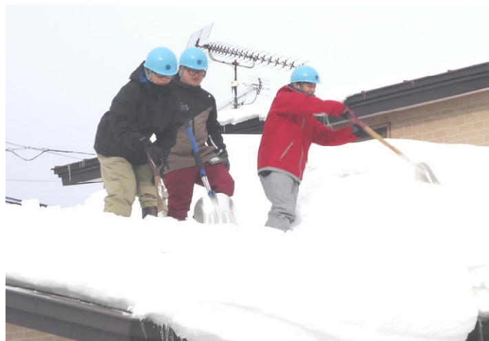
1メートルを超す屋根の雪を丁寧に下ろす。
